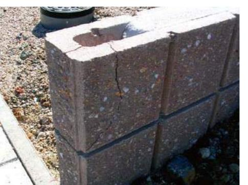
施工不良によりブロック内部へ雨水が浸入したため、内部に水がたまり、その水が凍結と融解を繰り返す凍結融解作用によって、ブロックが破壊されている例。
