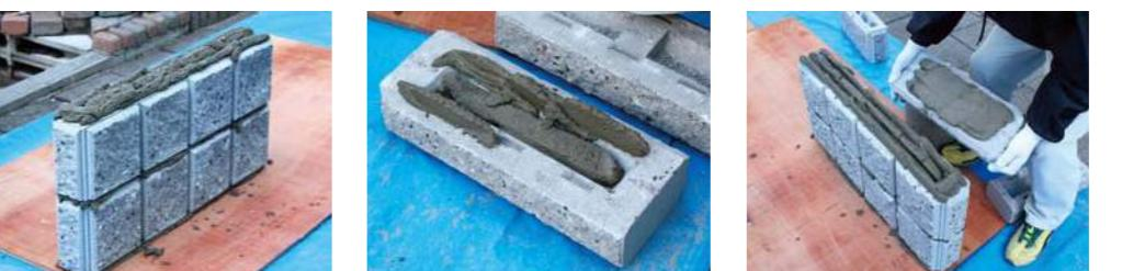
①(笠木を施工する) 埼の上部の真中、両端にモルタルを盛ります。
